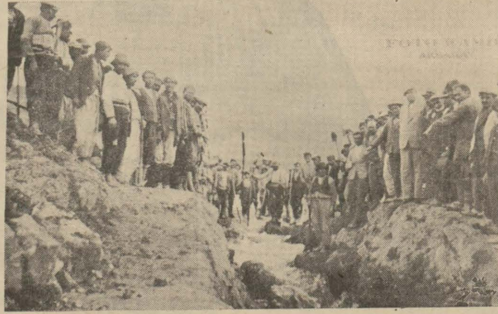
Karasaz bataklığının Helvadere köyü kısmında kanal açılırken
